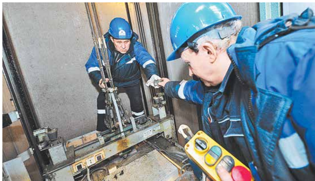
Профилактическое обслуживание лифтов сотрудниками ОАО «Мослифт»
