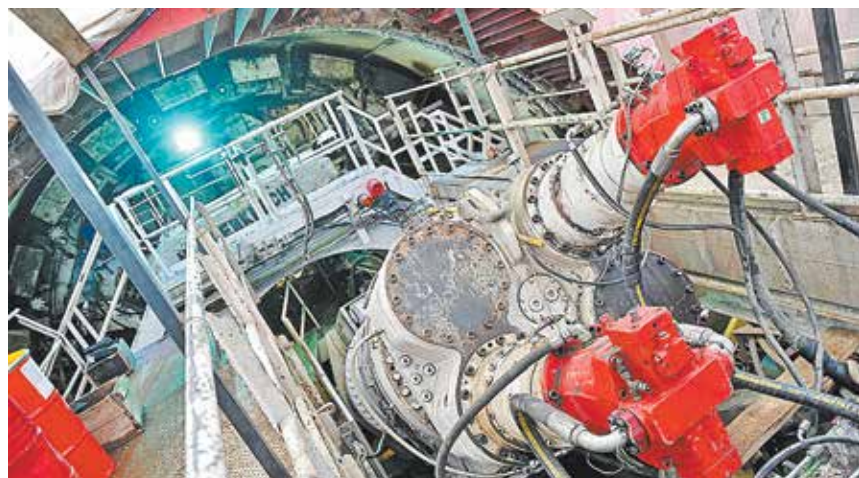
С помощью щита «Виктория» будет проложен тоннель от станции «Текстильщики» до «Печатников» (БКЛ)
