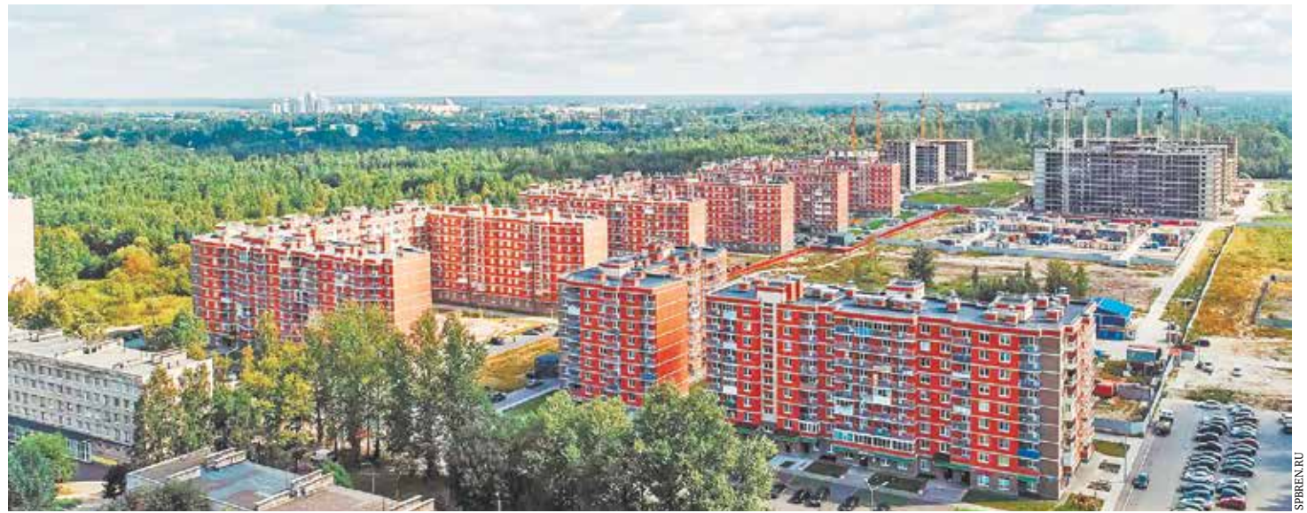
ЖК «Новое Колпино». Квартиры здесь получили жители домов, попавших под снос в ходе реализации программы реновации в Санкт-Петербурге
