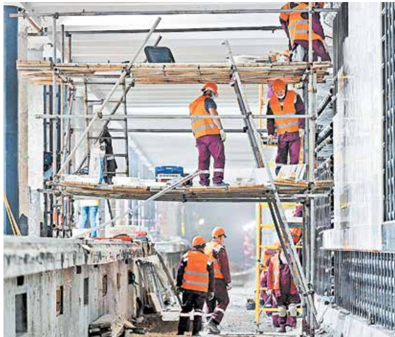
Станция метро «Каховская» после реконструкции войдет в состав Большой кольцевой линии
