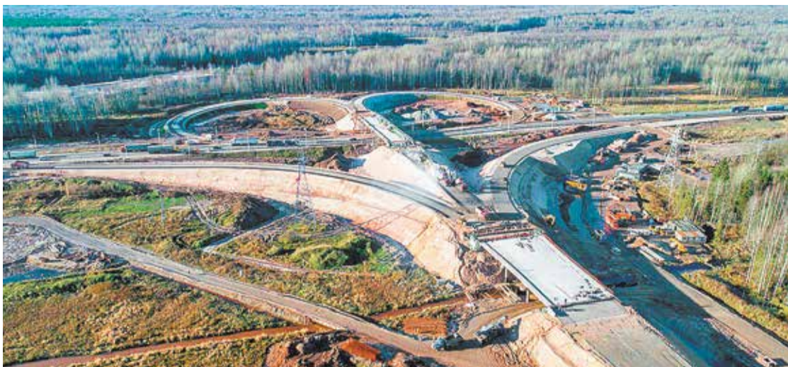
Строительство одного из путепроводов на федеральной трассе М-11 (Новгородская область)
