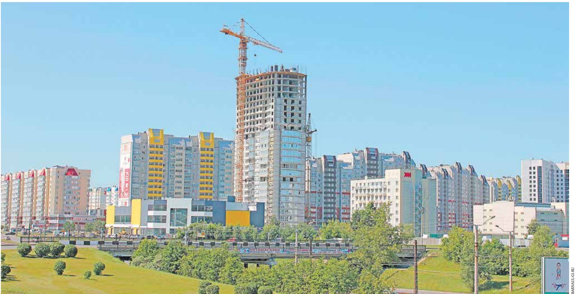
26-этажный многоквартирный дом в ЖК «Рубин» — самый высокий из строящихся в Алтайском крае
