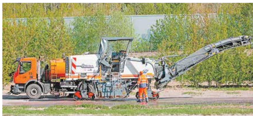
Технология холодного ресайклинга на дорогах Омской области
