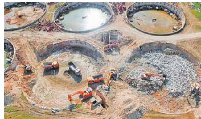
Строительство канализационных очистных сооружений «Южные» в Севастополе
