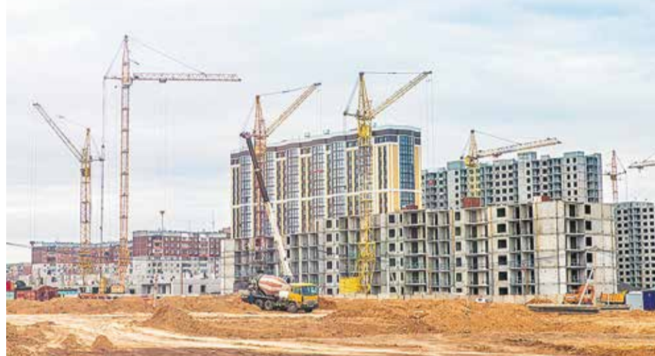
Один из строящихся жилых районов Барнаула (Алтайский край)
