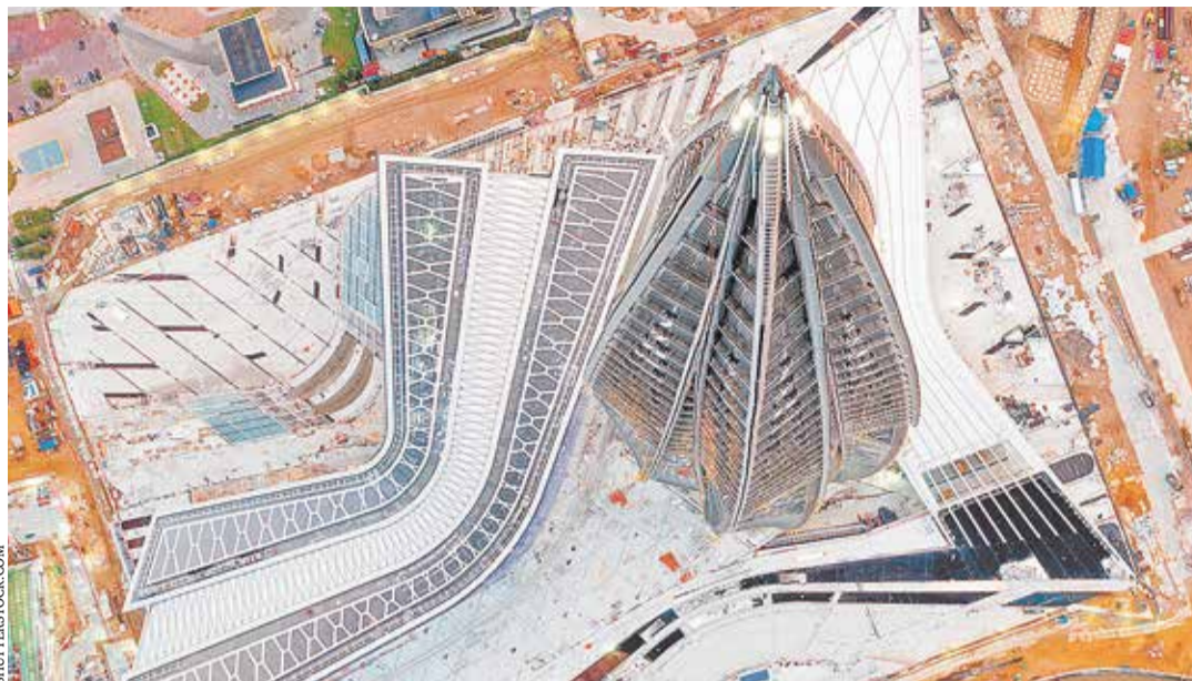
Сталежелезобетонные конструкции использовались при строительстве «Лахта Центра» в Санкт-Петербурге
