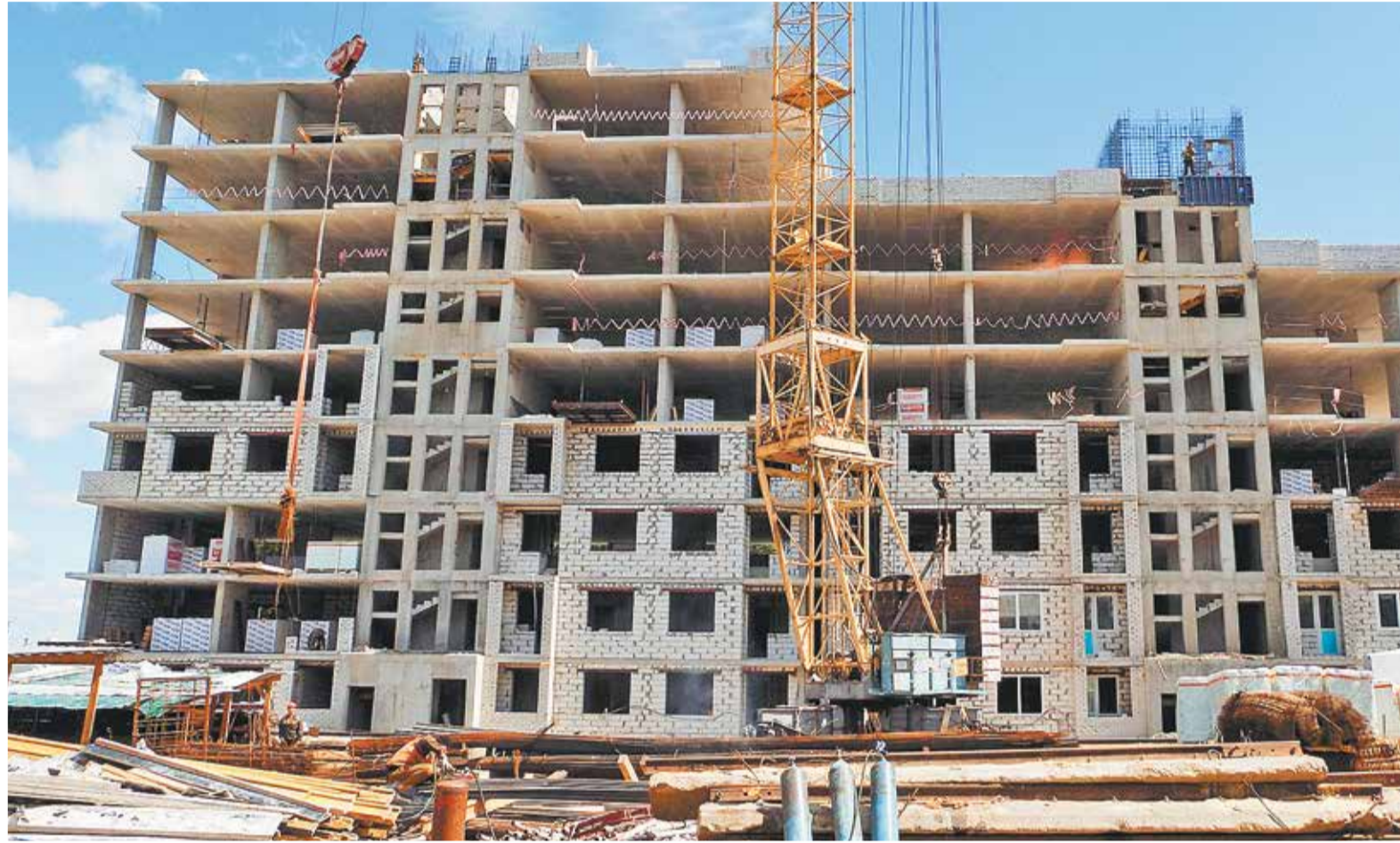
Строительство домов в Заводском районе Пензы для переселения граждан из аварийного жилья
