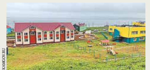
Строительство жилого дома в селе Никольское
