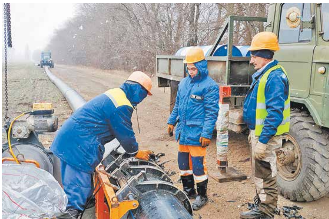
Работы по замене изношенного участка магистрального водовода в Кочубеевском районе Ставропольского края
