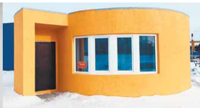
С помощью технологии 3D-печати дом площадью 38 кв. м в Ступине (Московская область) удалось построить за 24 часа
