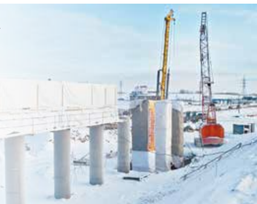
На реконструируемом участке трассы Р-23 построят девять инженерных сооружений
