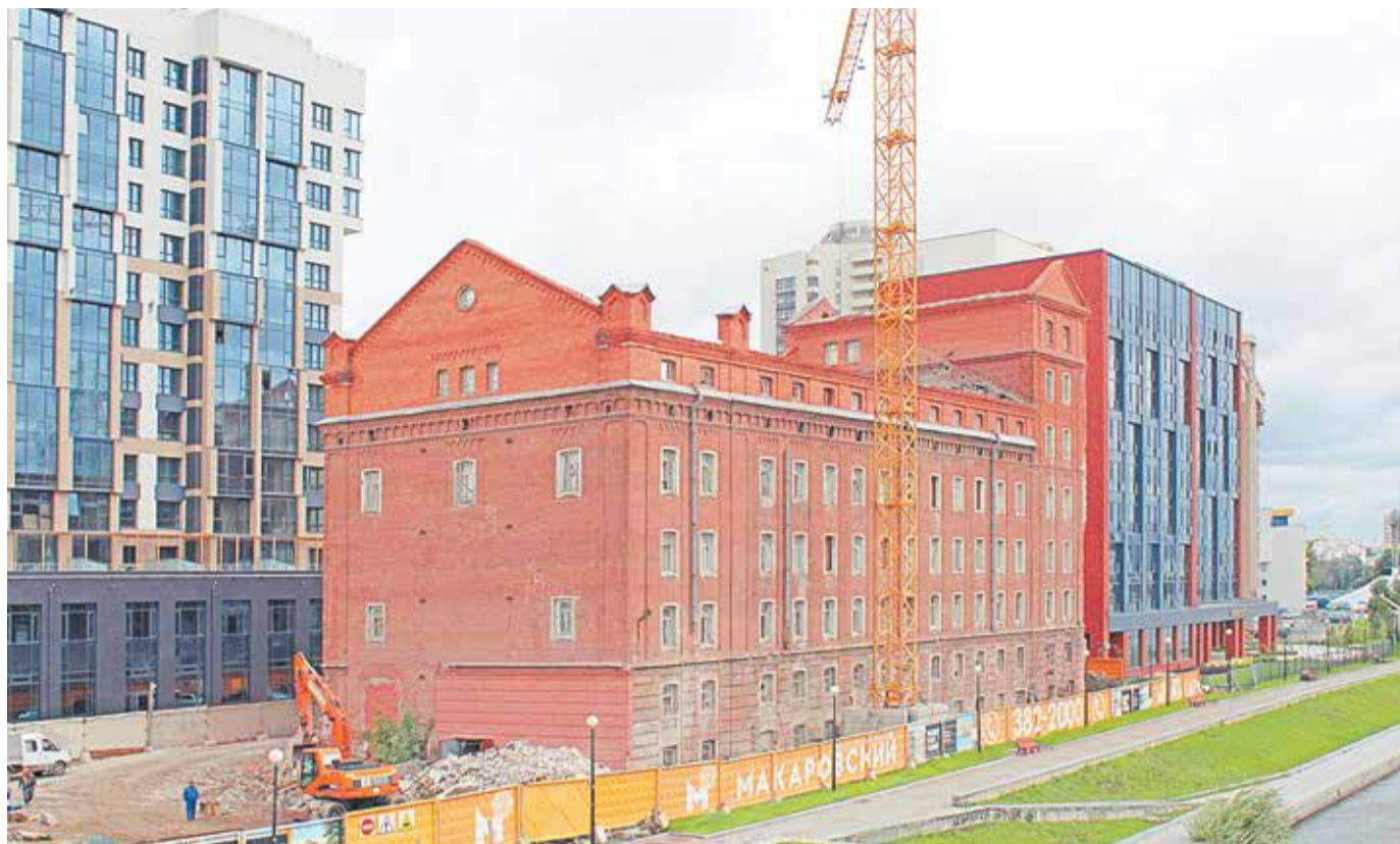
Строительство жилого комплекса «Макаровский квартал»
