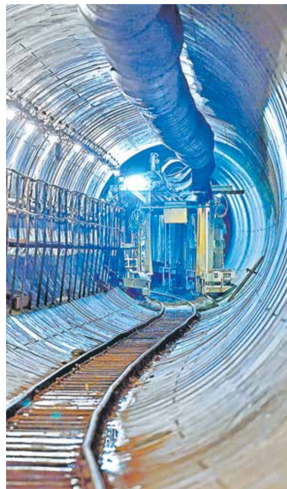
Строительство станции метро «Проспект Вернадского» (БКЛ)
