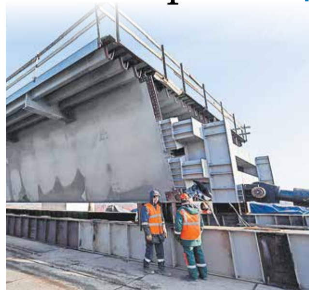
Строительство моста через Москву-реку вблизи города Бронницы
