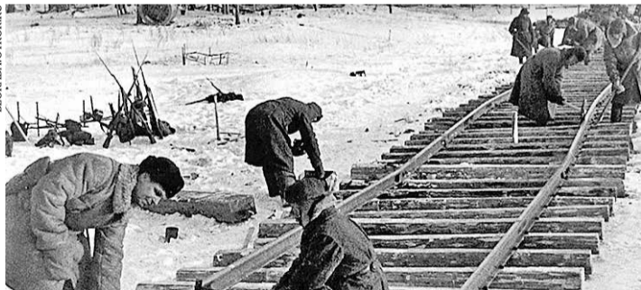
Укладка железнодорожного полотна по льду Ладожского озера
