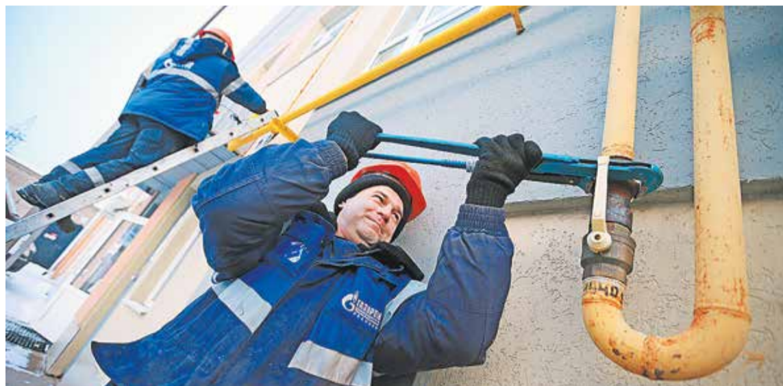
Проверка газового оборудования в одном из жилых домов города Иваново
