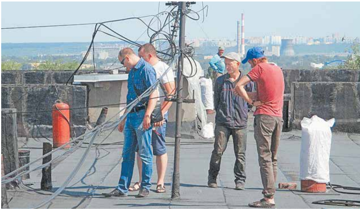
Проверка капитального ремонта дома № 26 по улице Хрустальной в Ульяновске
