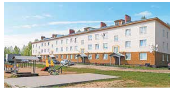
Один из домов в Вологодской области, где строительные дефекты были выявлены после зимнего сезона
