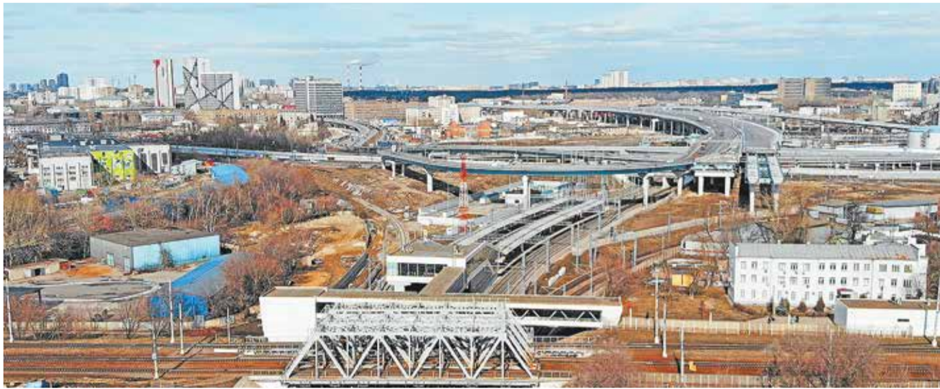
Путепровод через пути МЦК от улицы Пруд Ключики до 1-й Фрезерной станет частью Юго-Восточной хорды
