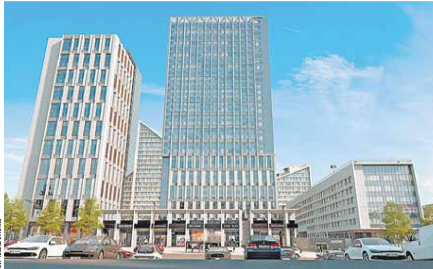
ЖК IDEL TOWER в Уфе
