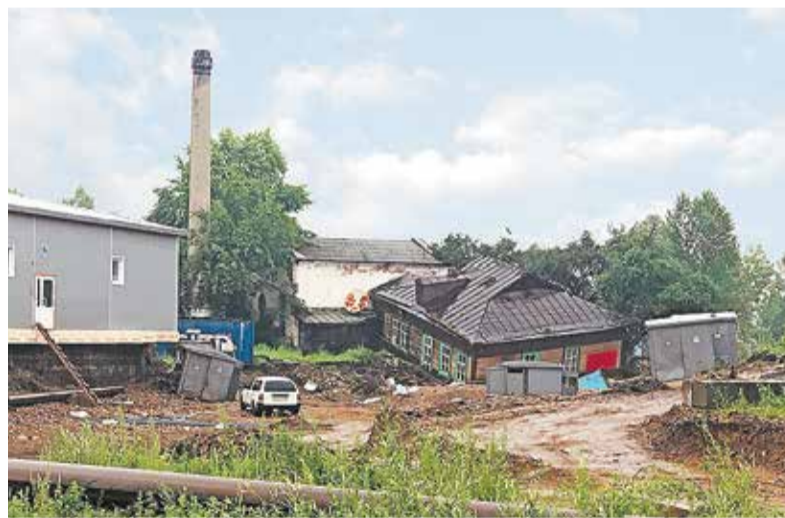
Городской водозабор в Нижнеудинске после наводнения
