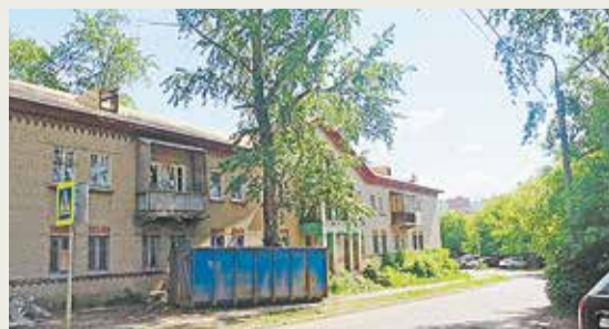
В доме № 2/22 по улице Толстого (Рязань) проводятся работы по замене кровли
