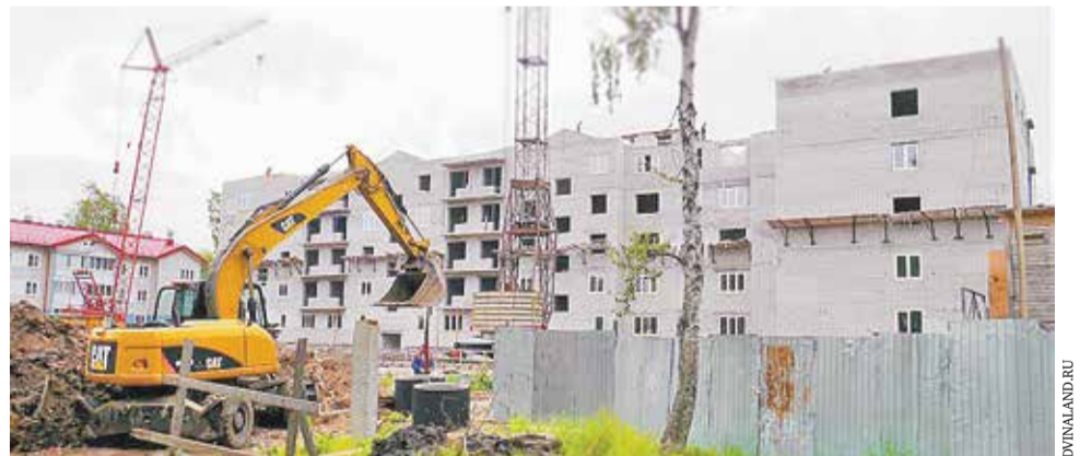
Строительство дома для переселения граждан из аварийного жилья (Северодвинск, Архангельская область)
