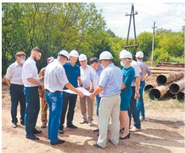
Представители Минстроя Чувашии и администрации Новочебоксарска ознакомились с ходом реконструкции систем теплоснабжения
