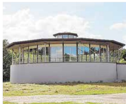
Новый водозабор в Тербунах
