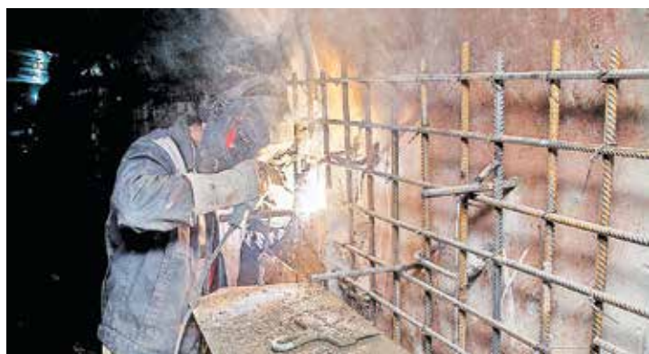
Фиксирование арматурной сетки
