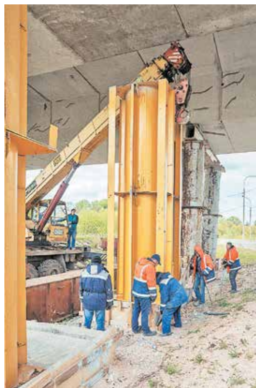
Монтаж временных опор
