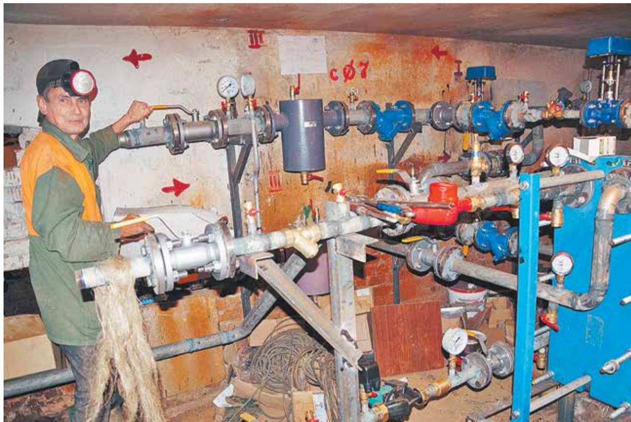
Замена узлов управления и регулирования потребления тепловой энергии в многоквартирном жилом доме в Чебоксарах
