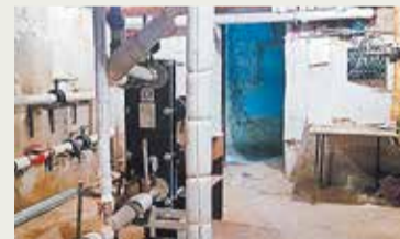
Энергоэффективный капремонт был проведен в доме № 4 на улице 9 Января в Ставрополе
