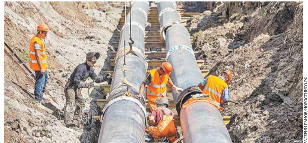
Реконструкция сетей тепло- и водоснабжения в Черепаново (Новосибирская область)
