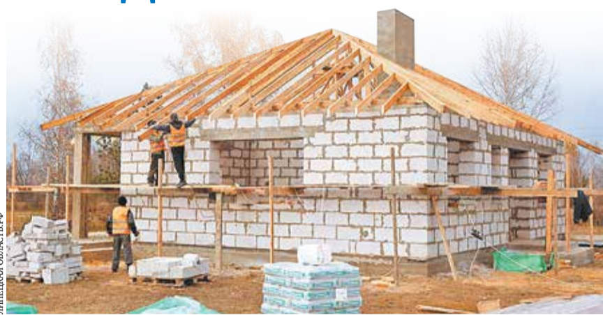
Строительство индивидуального жилищного дома в Липецкой области
