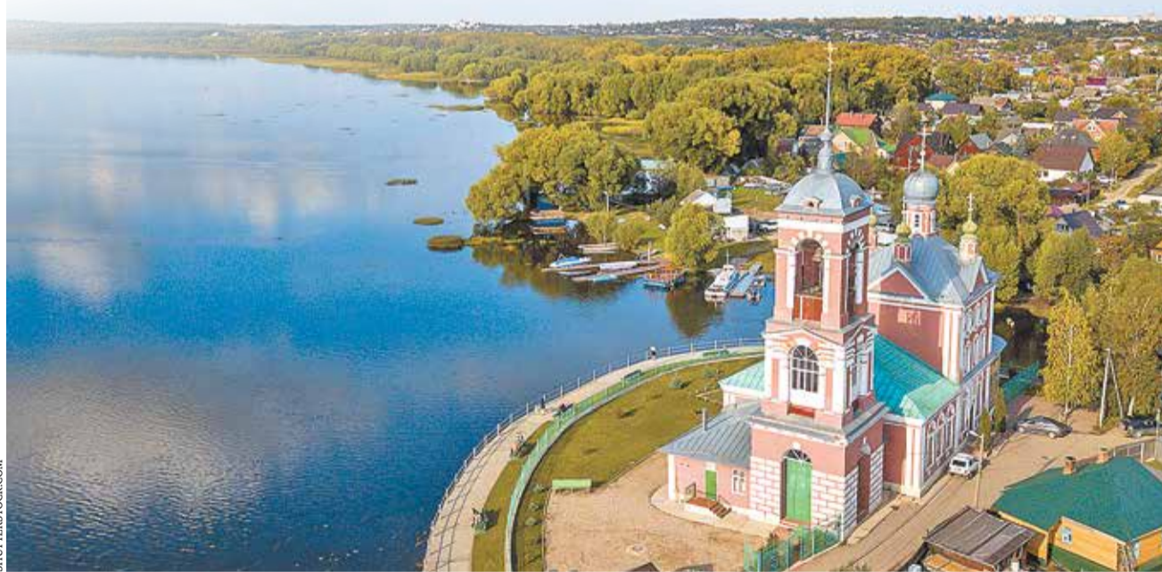
После реконструкции сетей водоснабжения Переславля снизится забор воды из Плещеева озера
