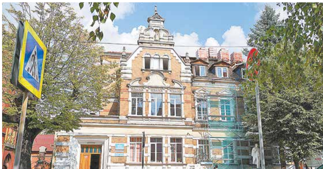
Ремонт объекта культурного наследия — Черняховской музыкальной школы
