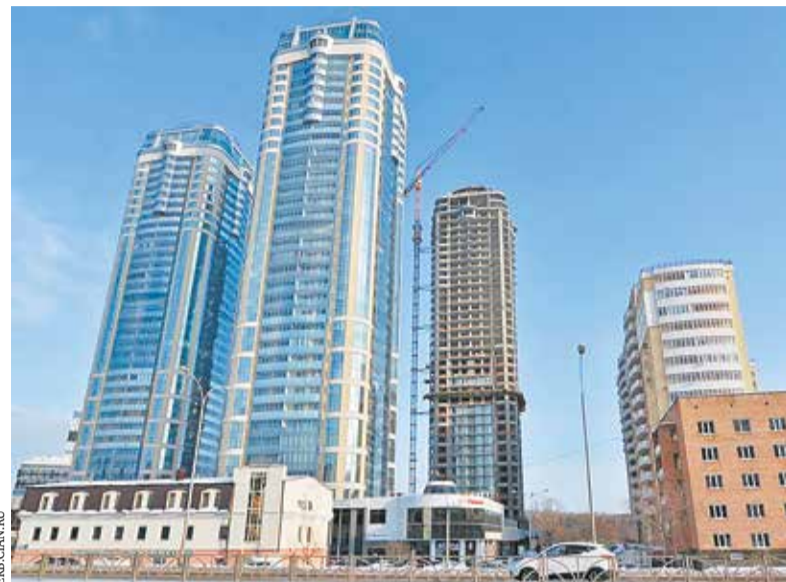
Строительство ЖК «Чемпион парк»
