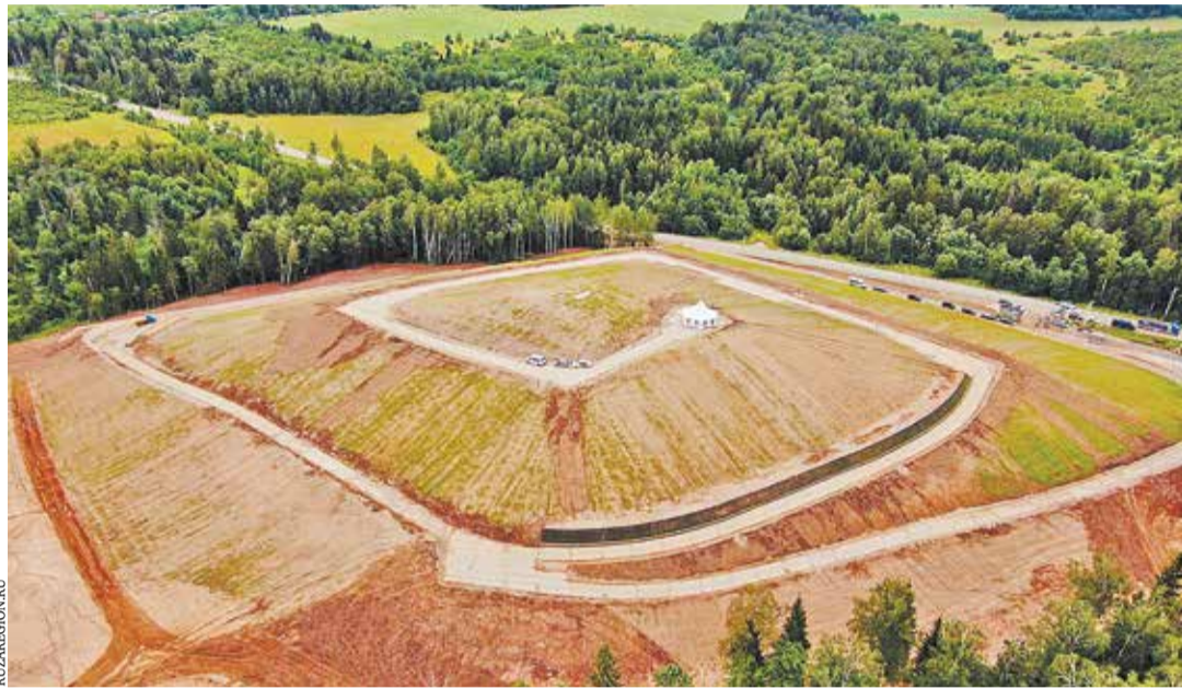
Рекультивированный полигон «Аннино» в Рузском районе Подмосковья
