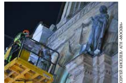
Демонтаж скульптур на фасаде бывшей аптеки Феррейна
