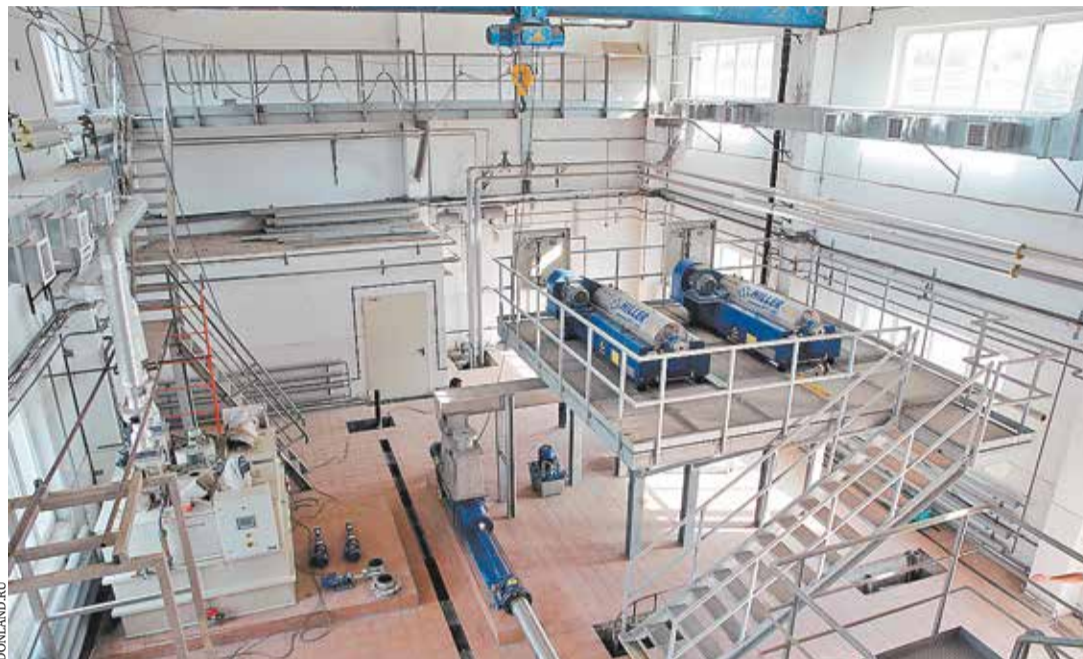
В поселке Каратаево Ростовской области завершается строительство водопроводных очистных сооружений
