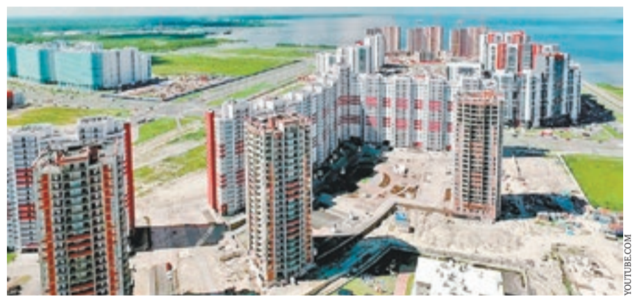
Один из петербургских «недостроев» — ЖК «Ленинский парк» в Красносельском районе
