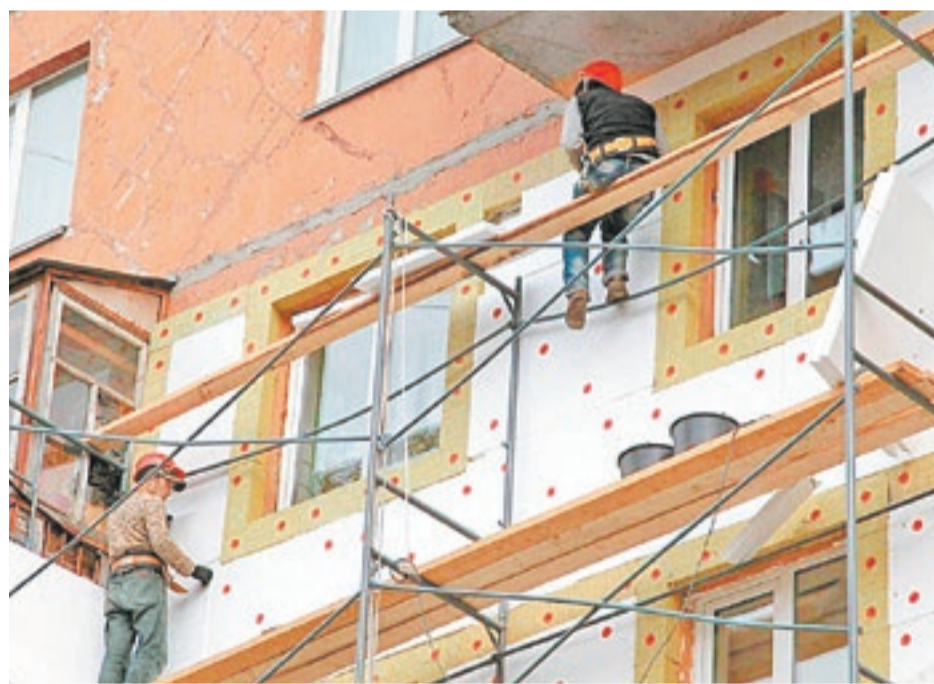
Капитальный ремонт многоквартирного дома в Уфе (Республика Башкортостан)
