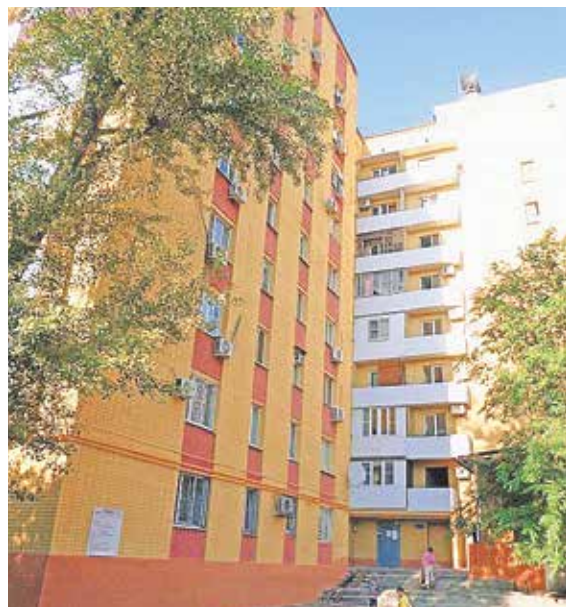
Дом на Каширской улице в Ростове-на-Дону после капитального ремонта
