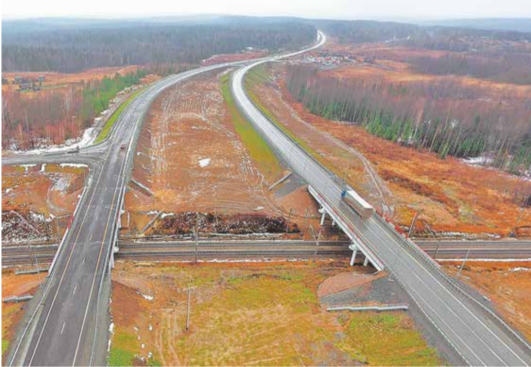
Путепровод через Транссиб на трассе Р-255 «Сибирь» (Красноярский край)
