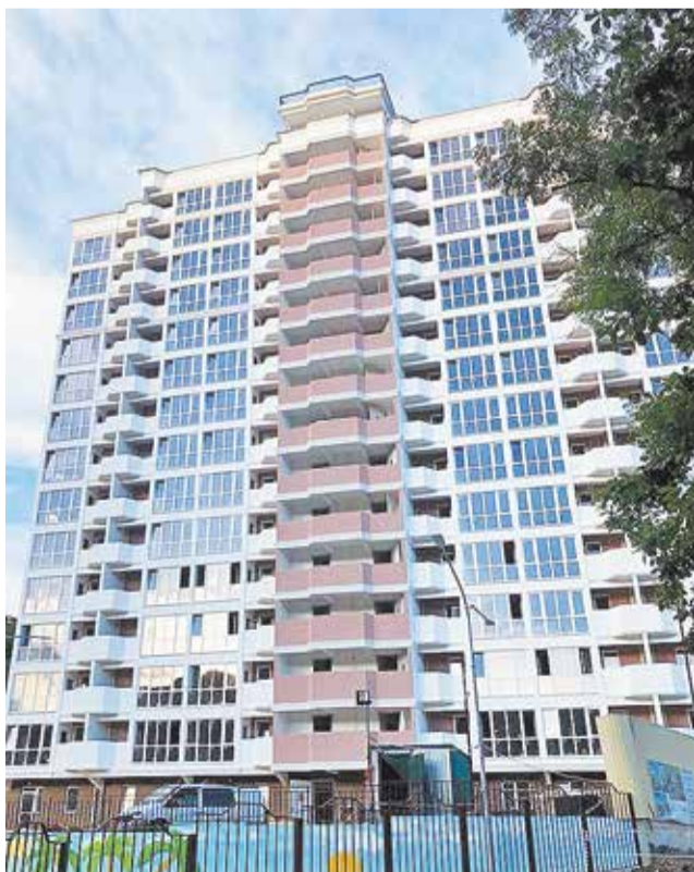
Отделка ЖК «Мацеста парк» (Сочи) с использованием фасадного декора из армированного пенополистирола
