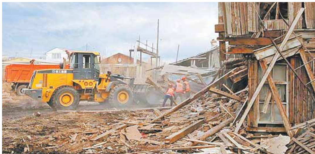
Снос аварийных домов в Якутске
