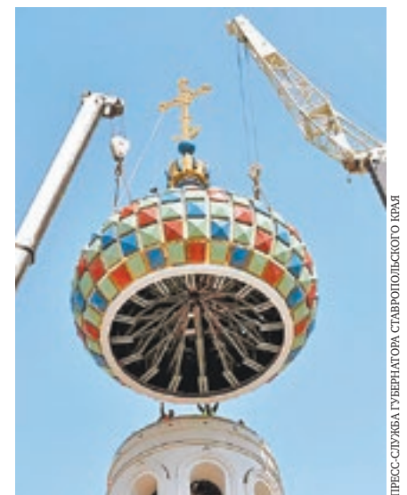
Установка купола на колокольню Казанского кафедрального собора в Ставрополе
