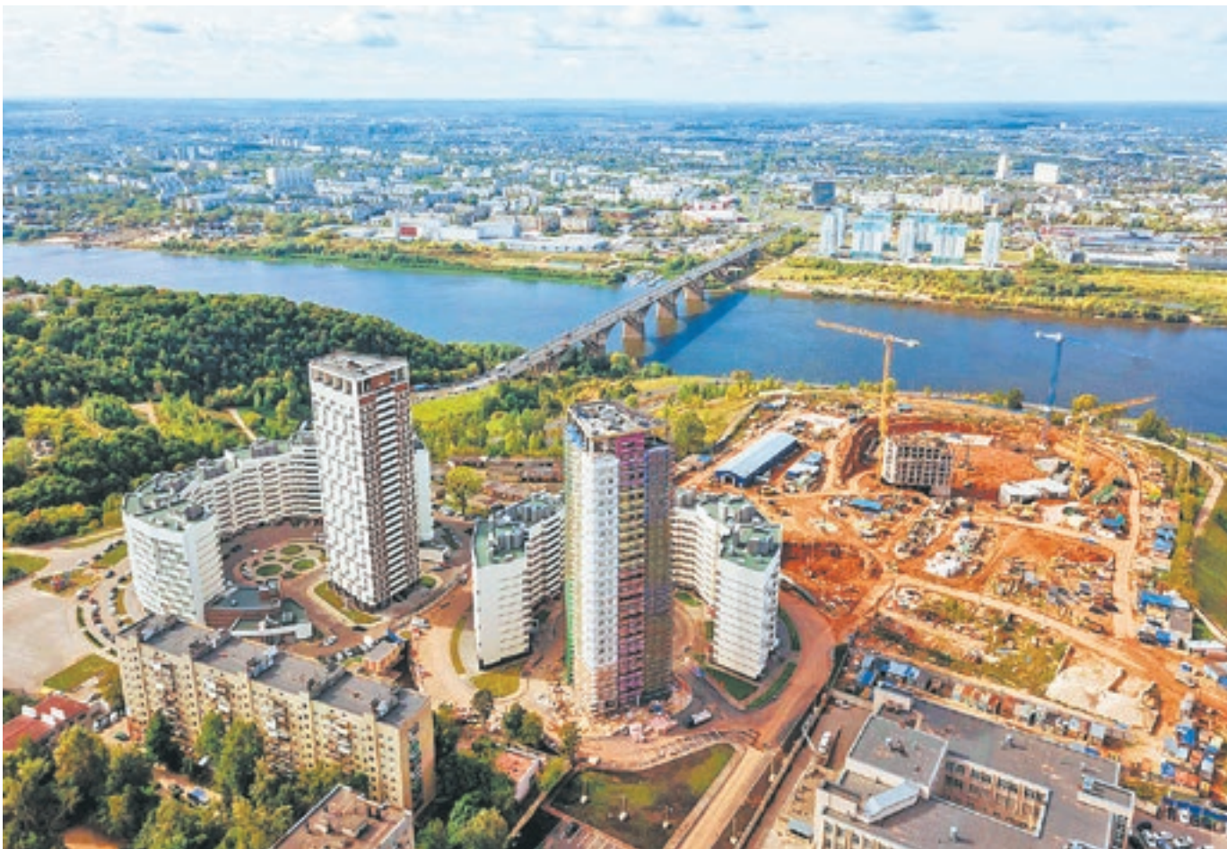
Самый большой дом, строящийся в Нижегородской области, — 28-этажный корпус в ЖК «Маршал Град»
