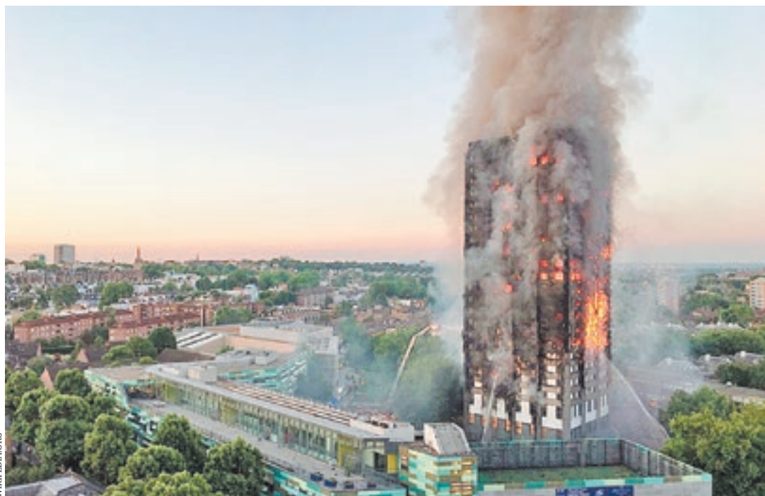
Пожар в здании Grenfell Tower в Лондоне 14 июня 2017 года
