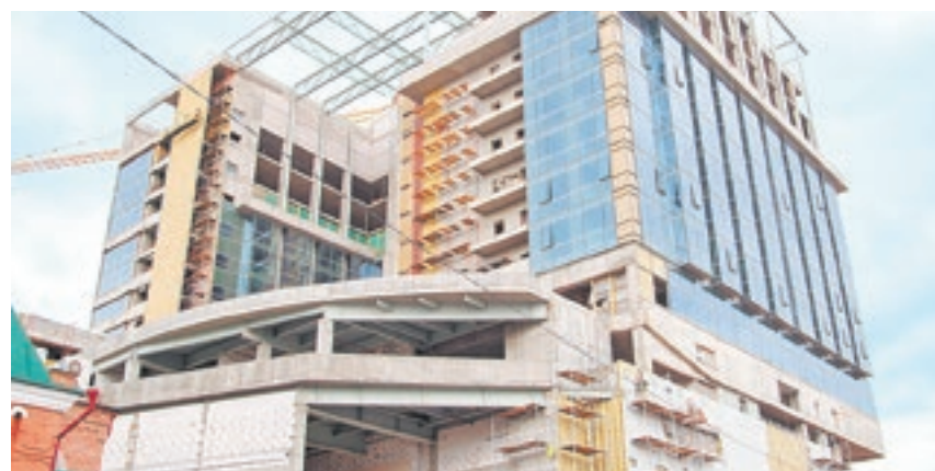
Недостроенное здание конгресс-отеля Hyatt Regency в Ростове-на-Дону
