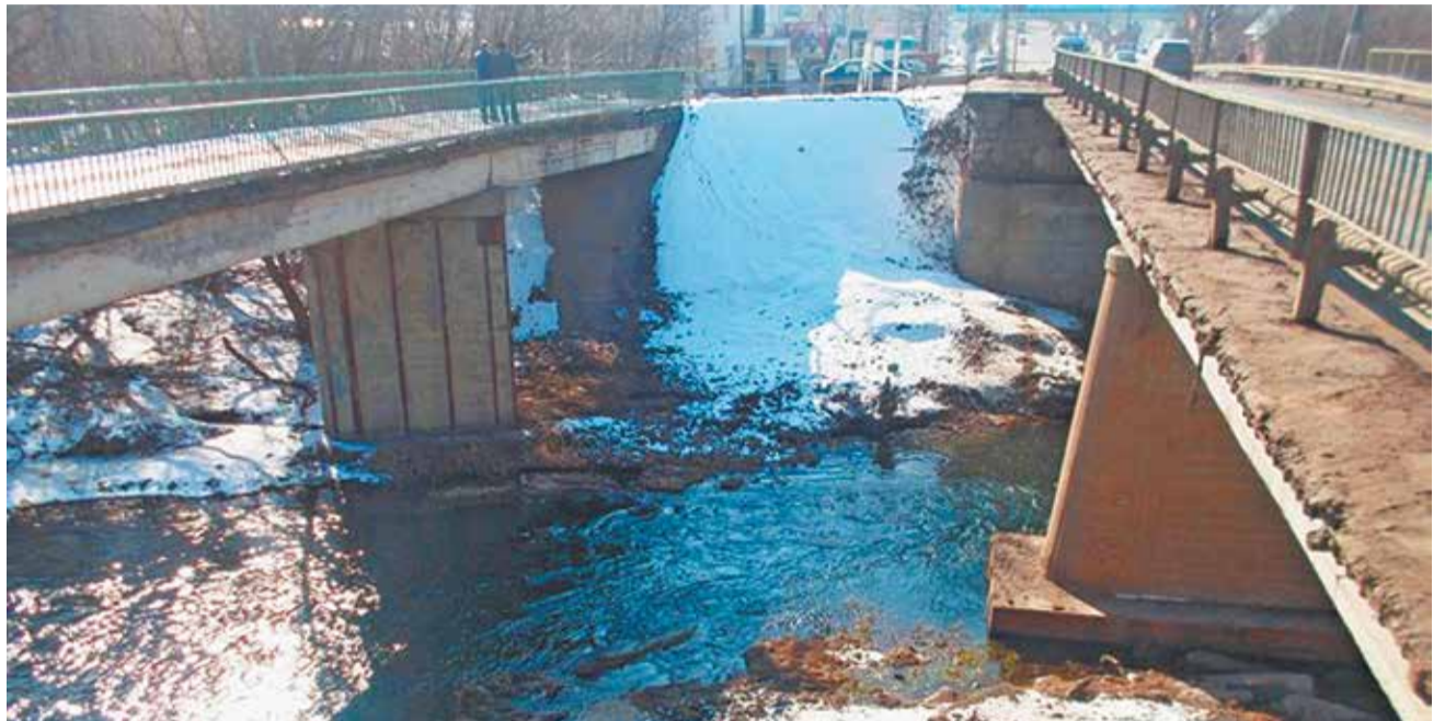
Фото 2. Мост через р. Плаву в г. Плавске Тульской области
