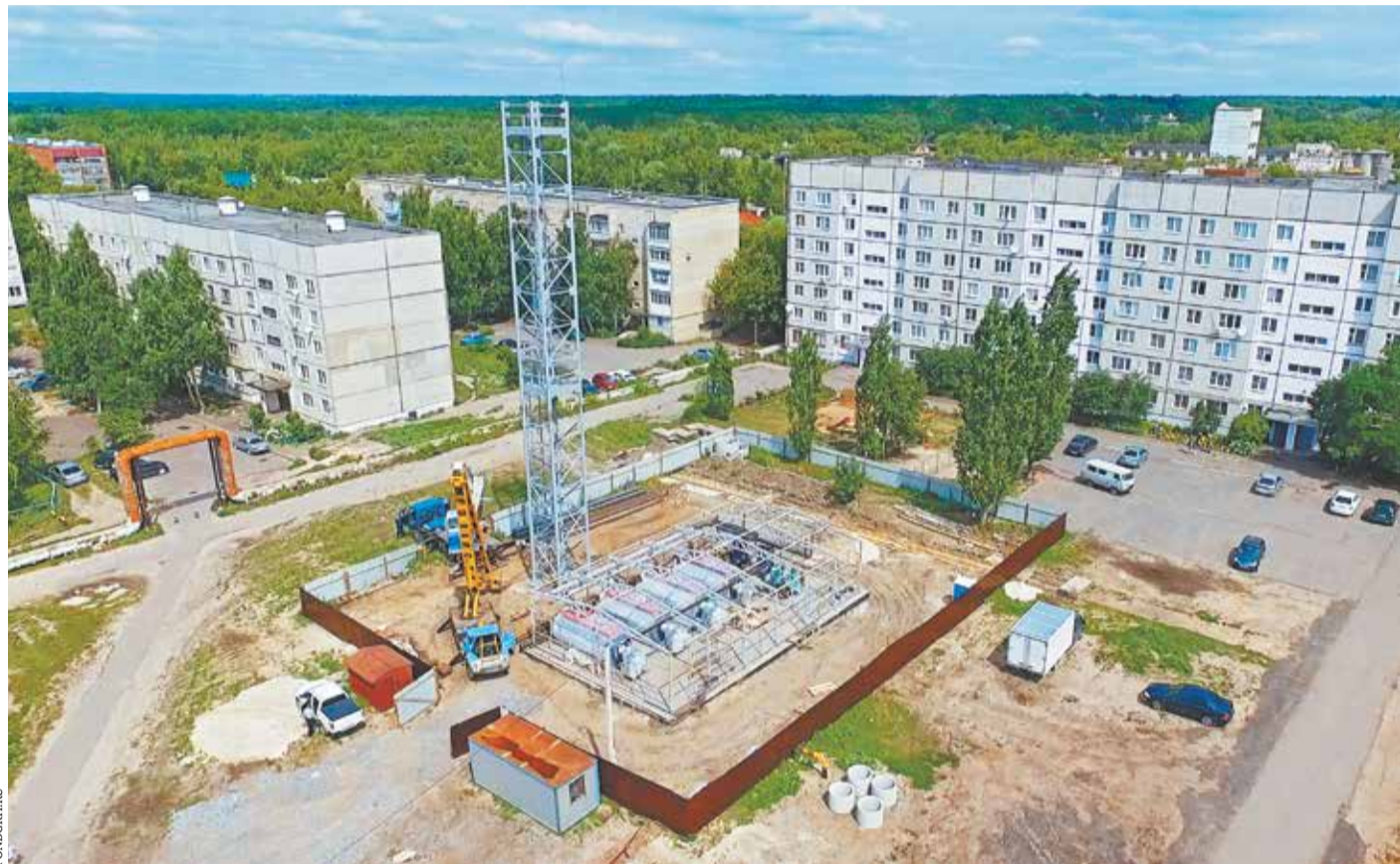
Строительство новых котельных в городе Котовске Тамбовской области
