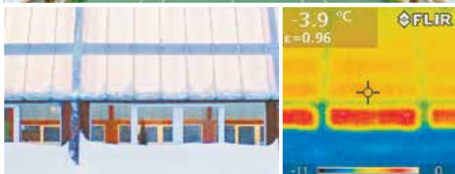
Высокая теплоизоляция NOVATTRO PROF подтверждается тепловизионной съемкой
