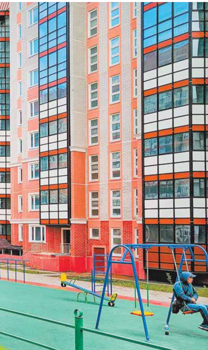
ЖК «Государев дом» в Ленинском районе Московской области
