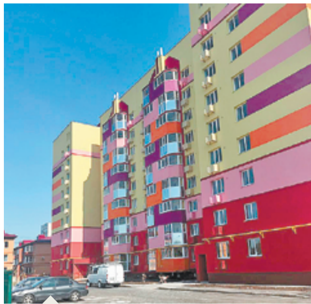
В Луховицах (Московская область) на улице Пушкина завершается строительство дома, куда из аварийного жилья передут 97 человек
