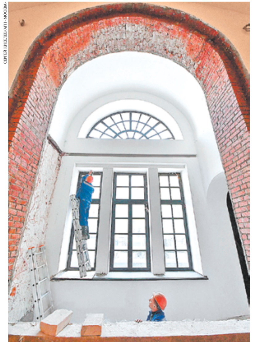
Во время реконструкции здания московского театра «Современник»
