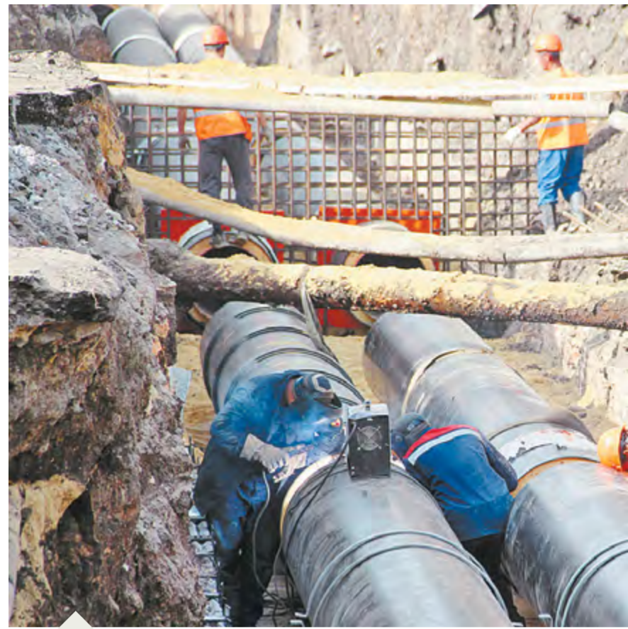
Замена теплотетей в ходе подготовки к отопительному периоду в Тамбове
