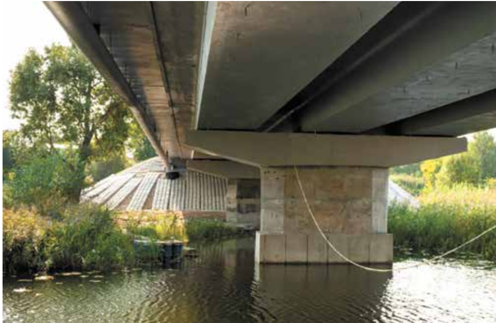
Рис. 5. Мост после реконструкции
