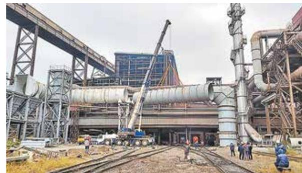
щих установок дуговых сталеплавильных печей № 1 и № 2, идет первый этап реализации проекта, включающий демонтаж старого оборудования и монтаж новых пылеулавливающих систем.
