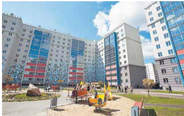
Жилой квартал «Смолинский» в Челябинске, в который в рамках реализации 185-ФЗ переезжают граждане, ранее проживавшие в аварийном жилье
