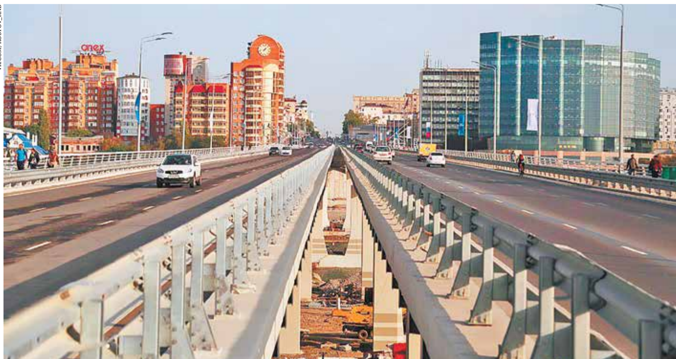
Обновленный Ворошиловский мост
