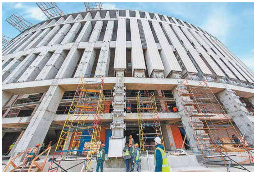
Во время строительства стадиона ФК «Краснодар»
