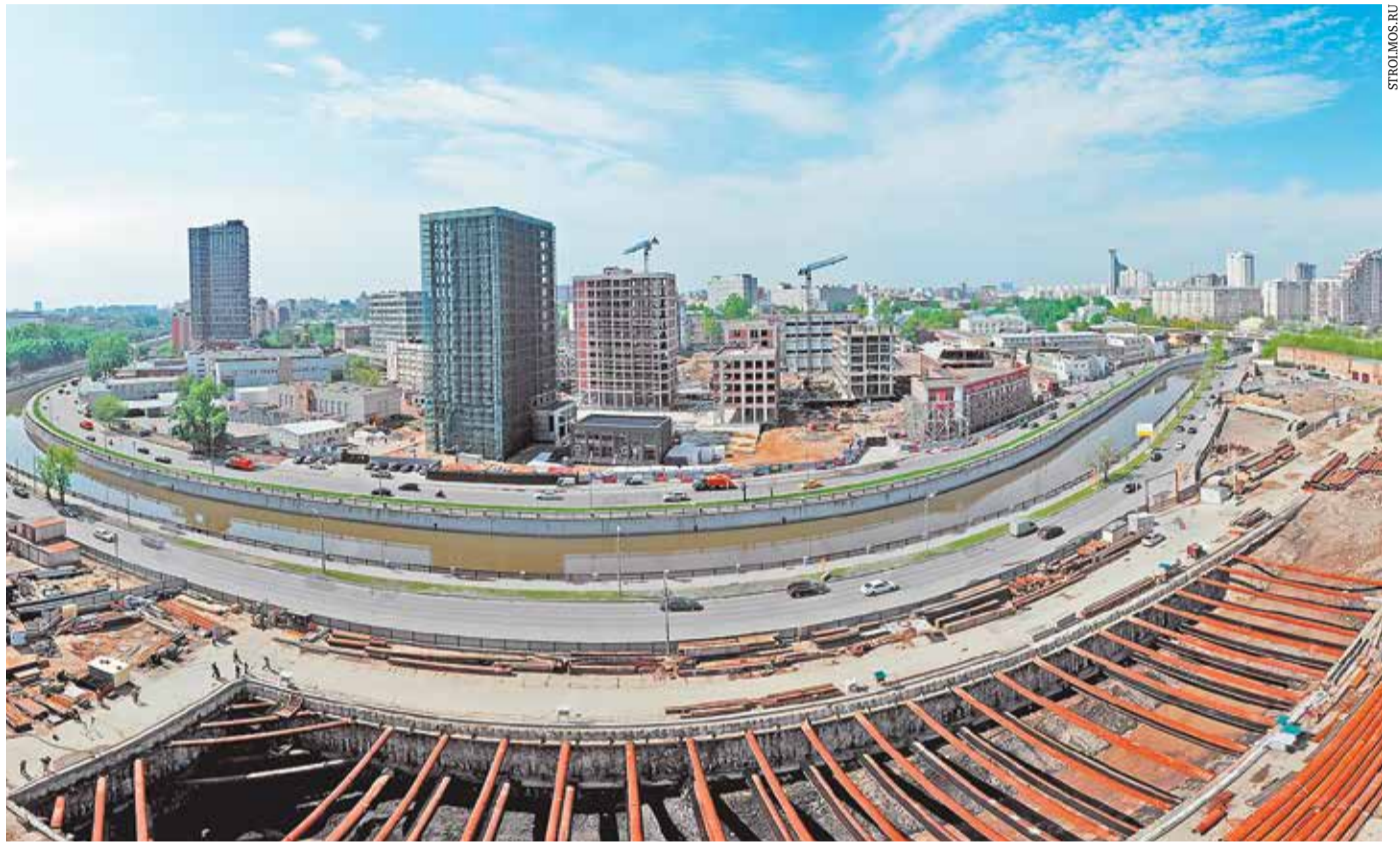
Строительство станции метро «Рубцовская» в Москве
