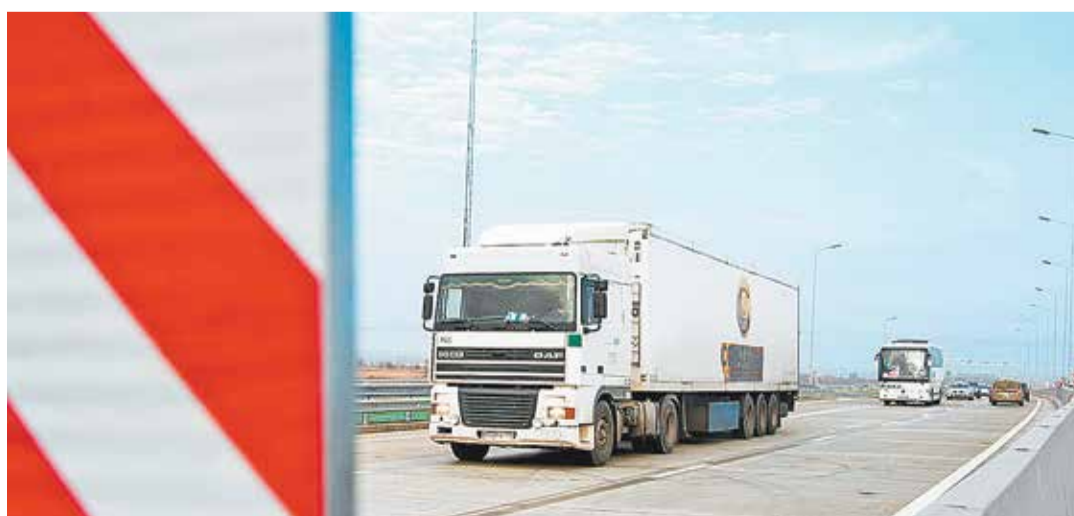
Открытие движения по обновленному участку федеральной трассы Р-22 «Каспий», построенному из цементобетона (октябрь 2017 года)
