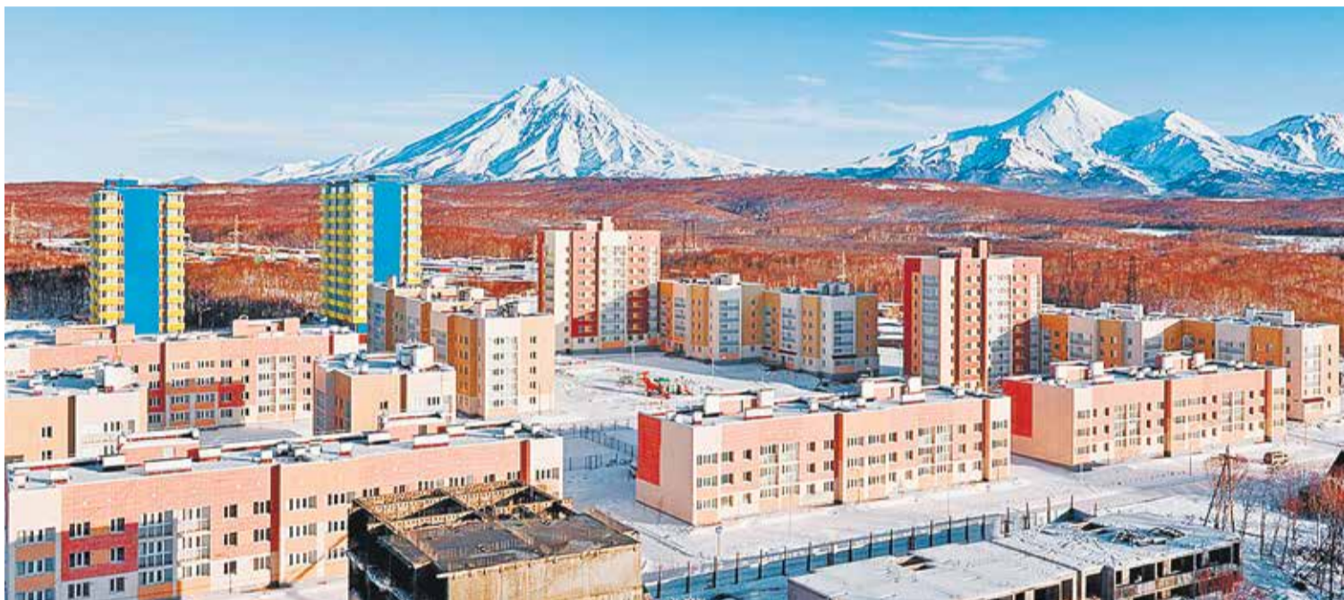
В микрорайоне «Северо-Восток» в Петропавловске-Камчатском возведены сейсмоустойчивые жилые дома
