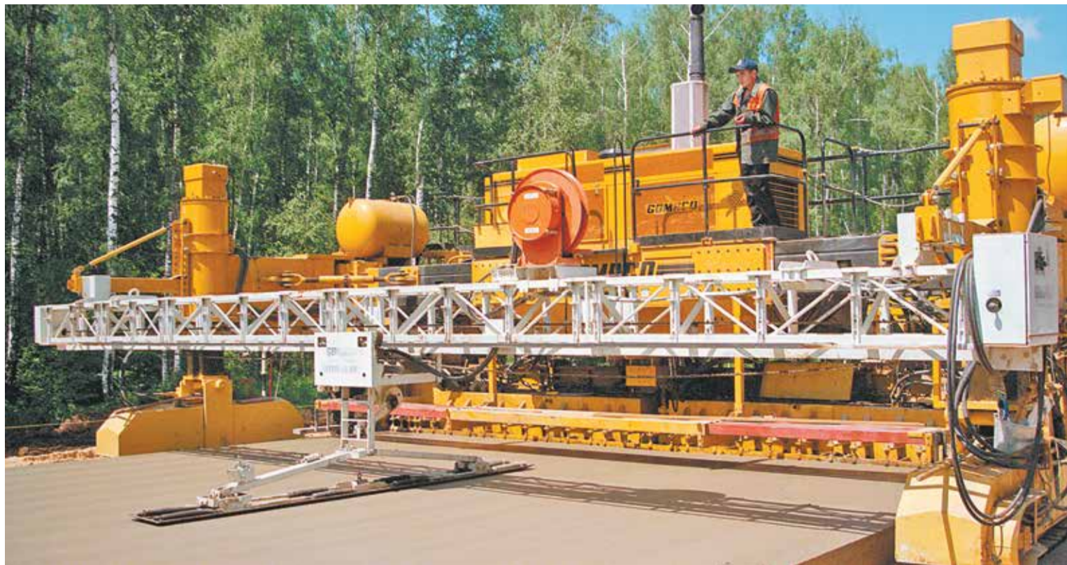
Создание цементобетонного покрытия комплексом «Гомак» на участке дороги «МКАД—Кашира» (июнь 1999 года)
