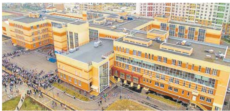
Школьный комплекс на 1400 мест в микрорайоне «Левенцовский» в Ростове-на-Дону
