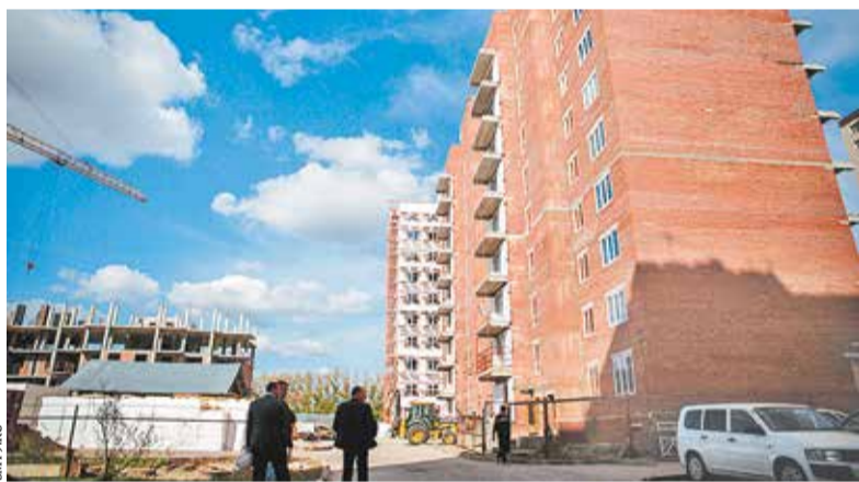
Стройплощадка на улице Петухова в Новосибирске
