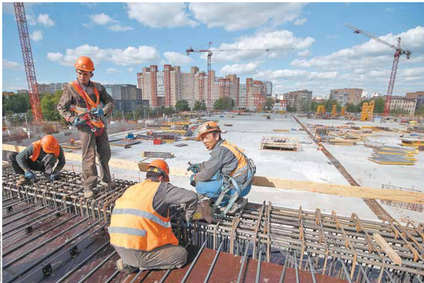
На строительной площадке стадиона «Динамо»
