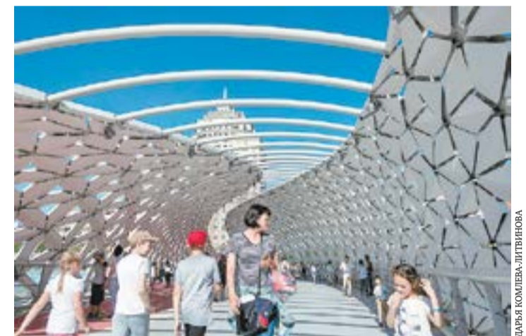
Мост через реку Есиль
