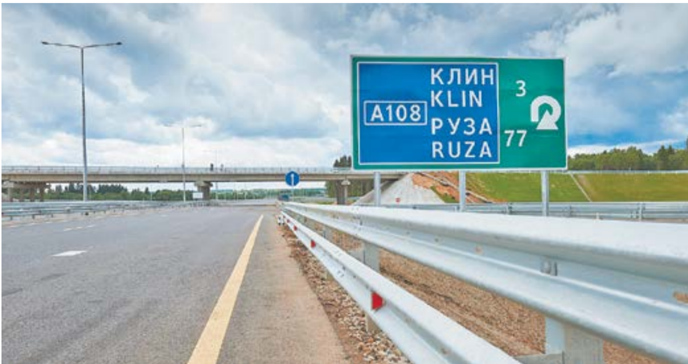
Участок трассы М11 Москва — Санкт-Петербург в обход Солнечногорска и Клина
