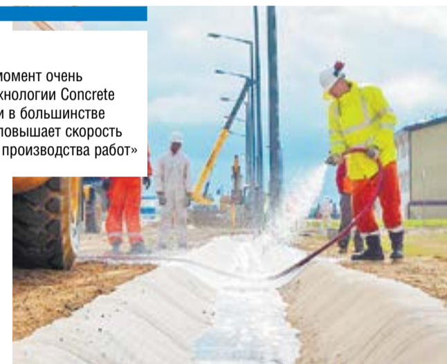
Укрепление дренажной канавы берегового комплекса Чайво на Сахалине с применением технологии Concrete Canvas
