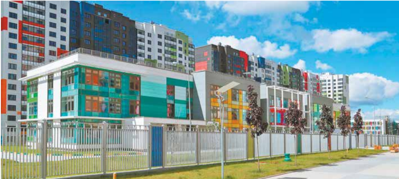
Детский сад в районе Северный на северо-востоке столицы, построенный по проекту повторного применения
