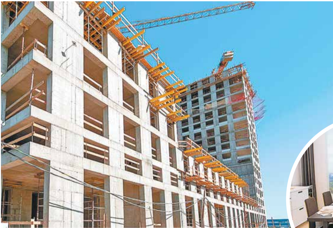
Строительство жилого комплекса с апартаментами «Level Амурская»
