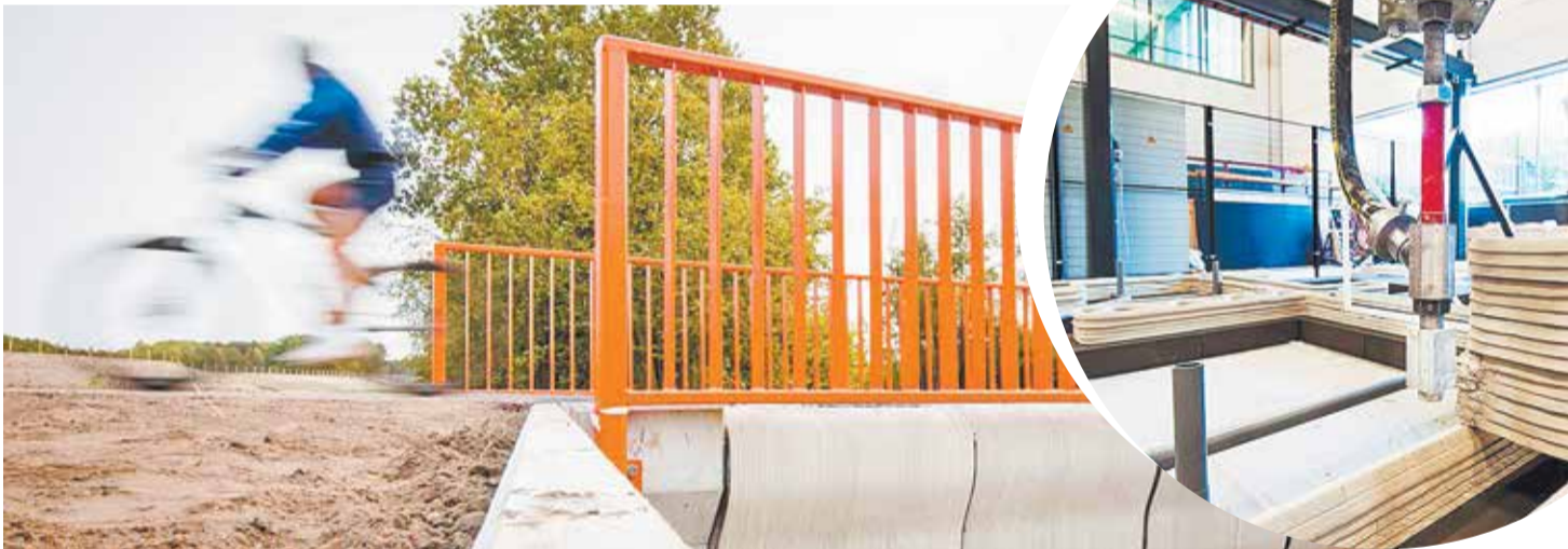
Первый в мире мост, созданный с помощью 3D-принтера (Гемерт)
