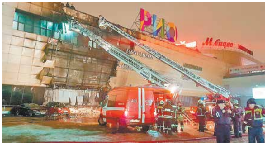
Последствия пожара в ТРЦ «РИО» на юго-западе Москвы
