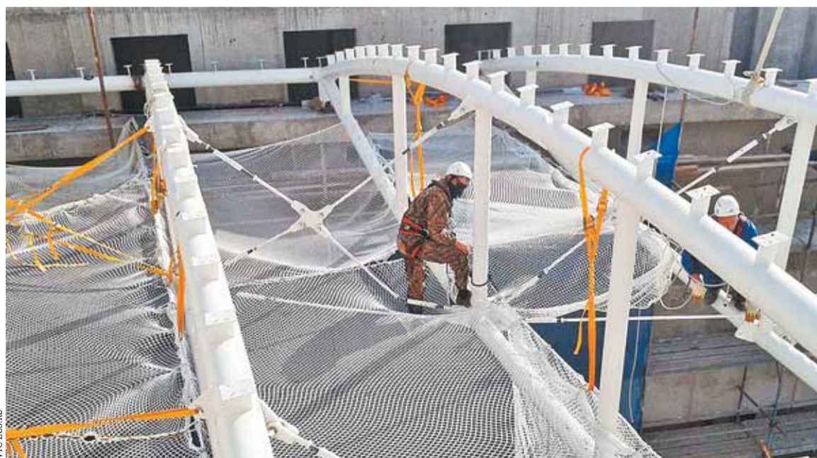
Монтаж защитно-улавливающей сетки
