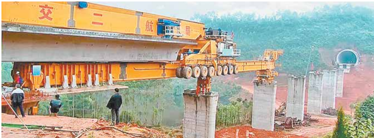
580-тонный мостоукладчик SLJ900/32 предназначен для возведения длинных мостов, состоящих из большого количества пролетов
