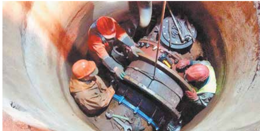
Архангельский «Водоканал» нуждается в серьезной модернизации
