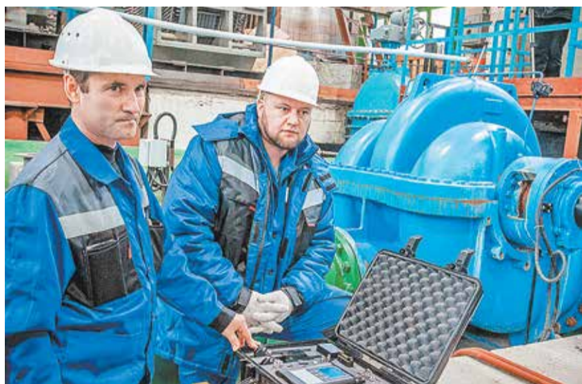
Лазерное оборудование «КВАНТ-ЛМ» используется для центровки насосных агрегатов, это повышает надежность работы всей системы в целом
