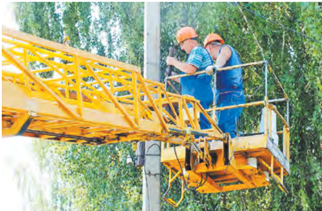
Замена старых светильников в Моршанске (Тамбовская область)
