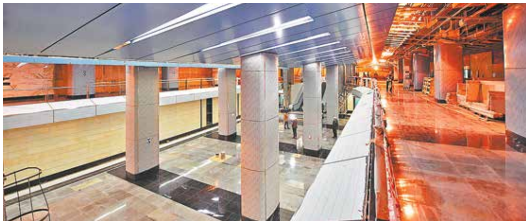
На станции «Деловой центр» Третьего пересадочного контура идут отделочные работы
