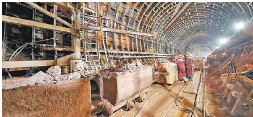
На строительстве станции «Верхние Лихоборы»
