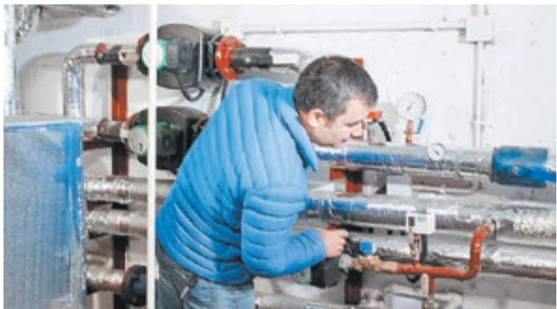
Работы по установке автоматизированного индивидуального теплового пункта в жилом доме в Калининграде
