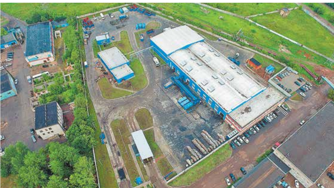
Мусороперегрузочная станция в городе Чебоксары
