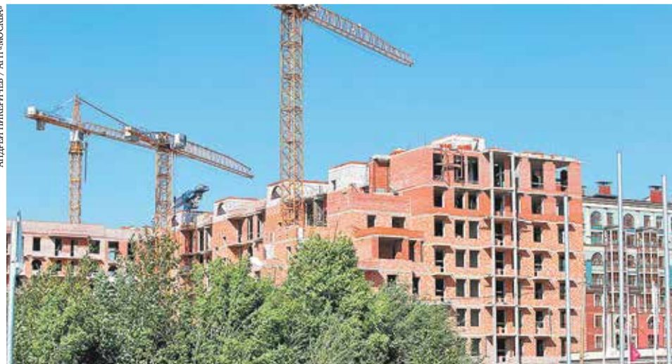
Строительство ЖК «Видный город»
