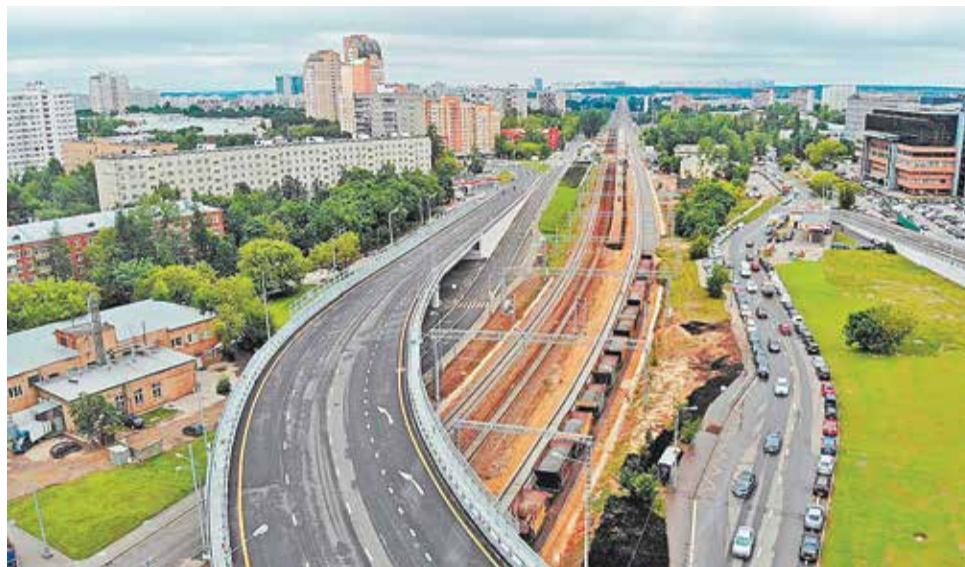
В июле 2018 года открылось движение по двум эстакадам на участке Северо-Западной хорды от Рублевского до Можайского шоссе
