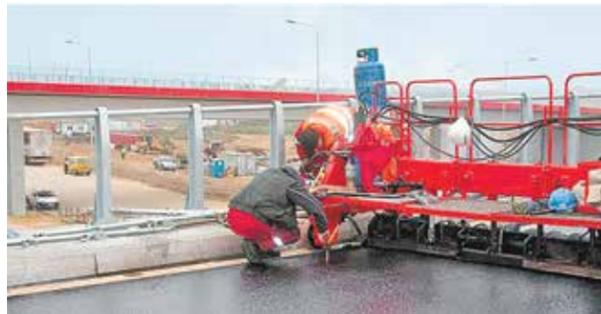
Процесс укладки покрытия из литого асфальтобетона
