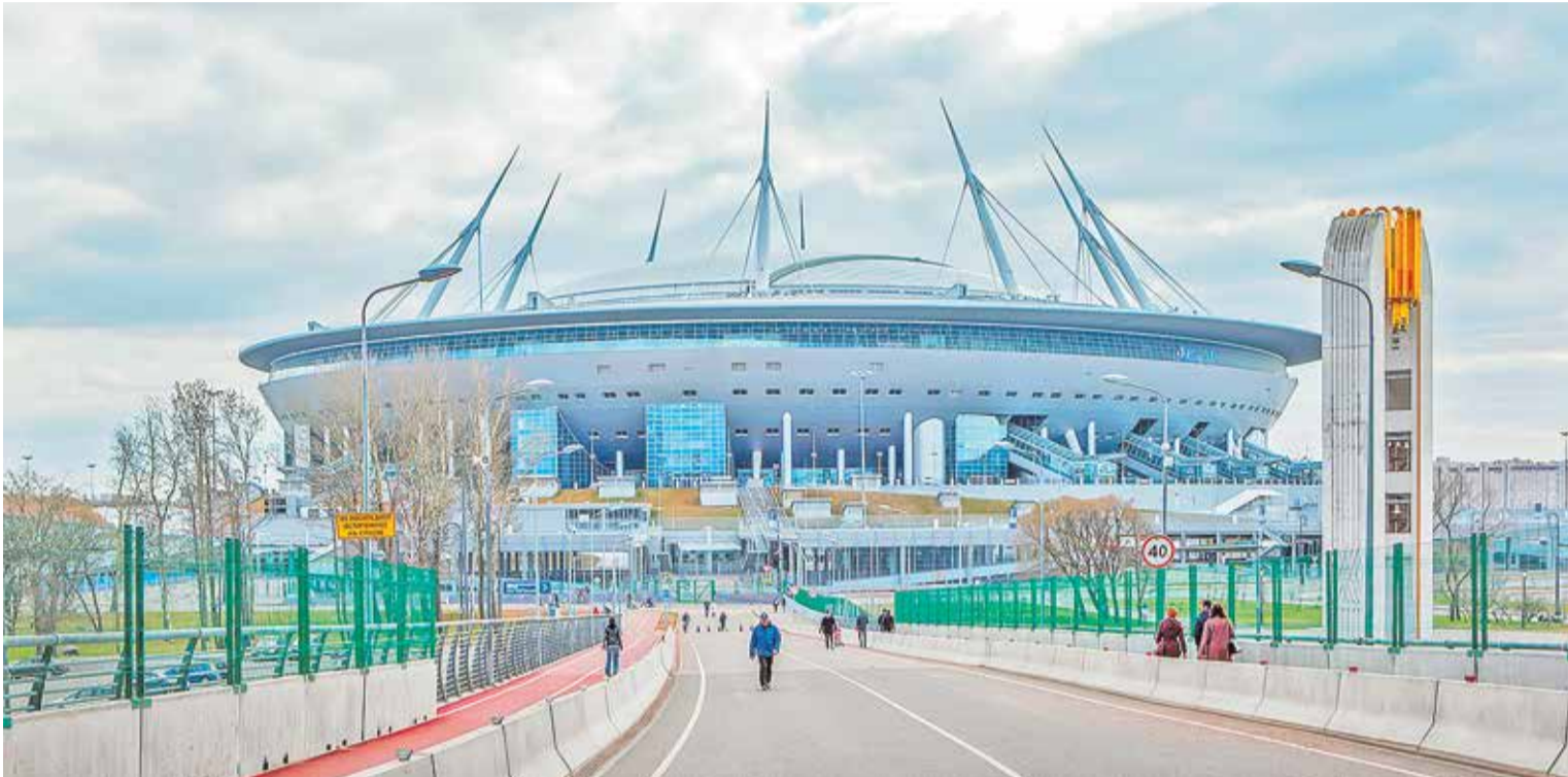
Стадион «Газпром Арена» («Зенит Арена») на Крестовском острове в Санкт-Петербурге. В процессе строительства его стоимость выросла с первоначально заявленных 6,7 млрд рублей до 43 млрд рублей (по другим данным, до 50,8 млрд рублей)
