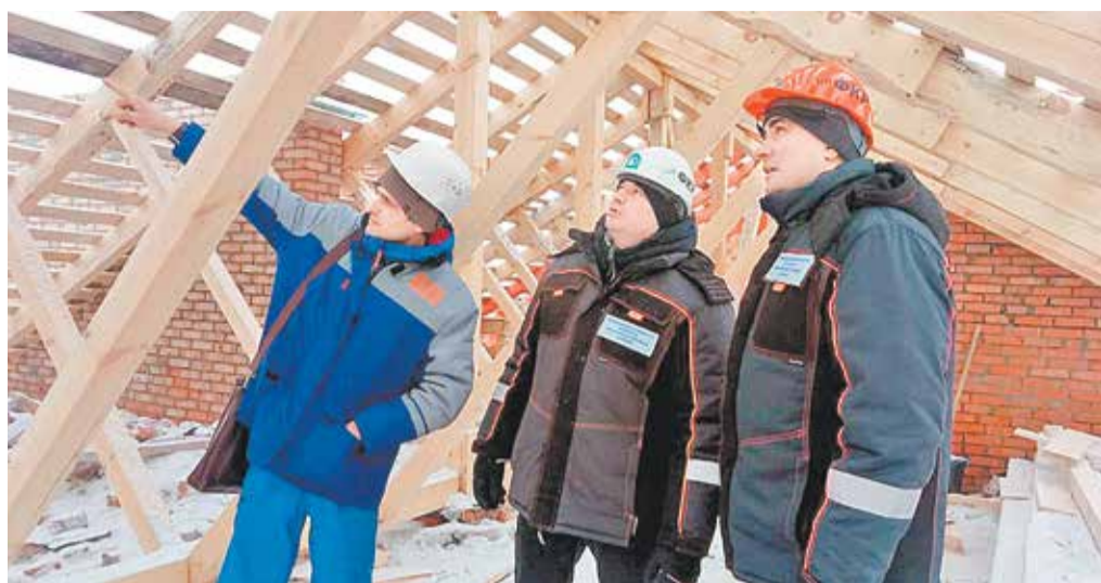
Капитальный ремонт кровли в многоквартирном доме в городе Камень-на-Оби (Алтайский край)
