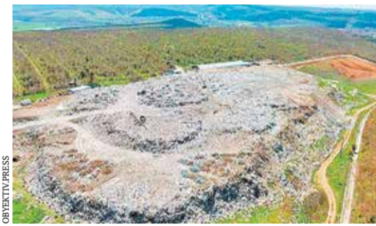
Полигон твердых бытовых отходов «Первомайская балка» в Севастополе
